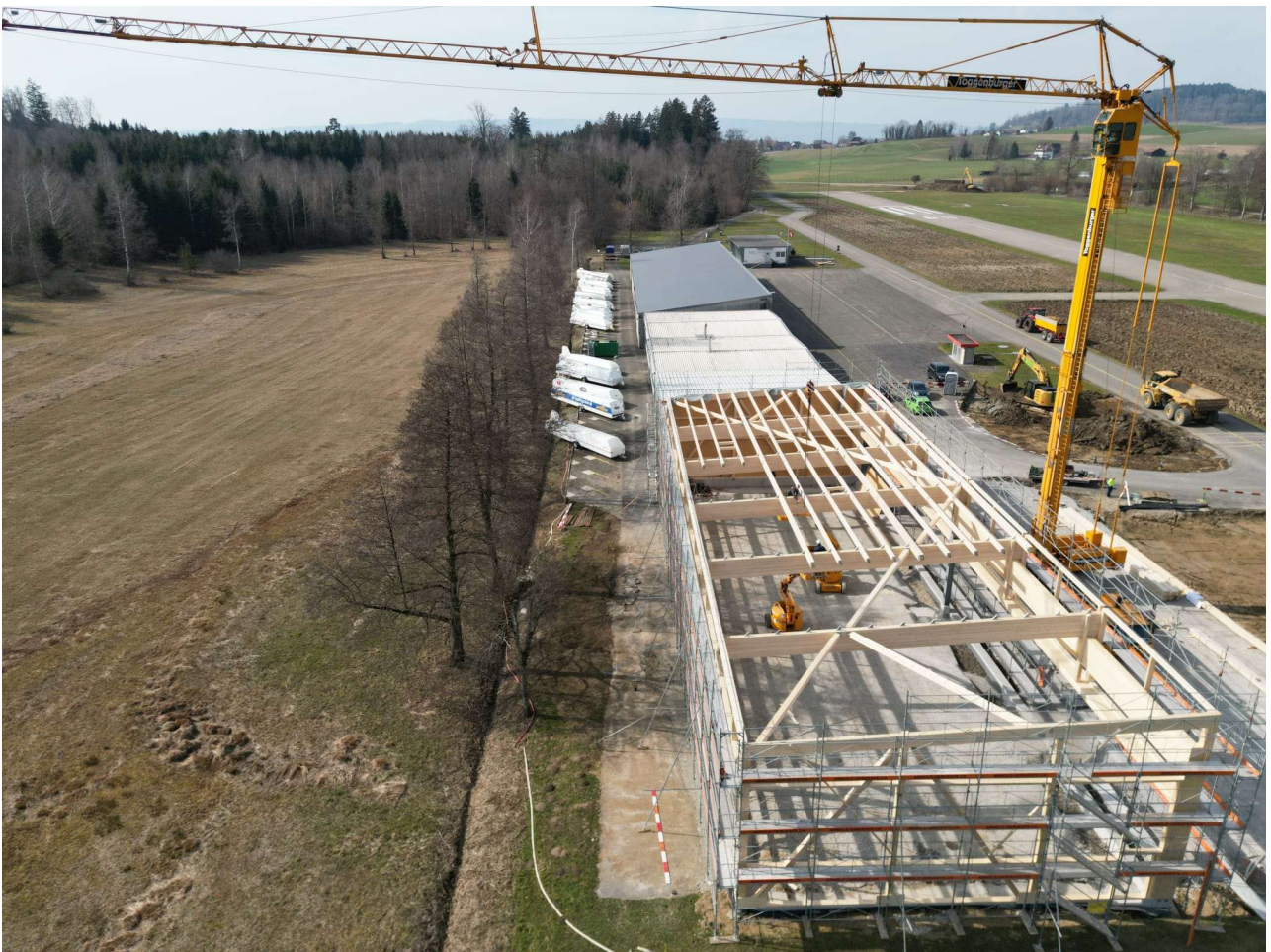
Der Hangar Neubau während der Phase des Aufrichtens der eleganten Holzkonstruktion.
